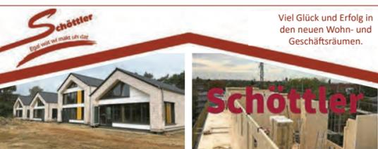
Ausführung der gesamten Aufstockung in energetischer Holzrahmenbauweise mit maximaler Vorfertigung in der Werkstatt.
